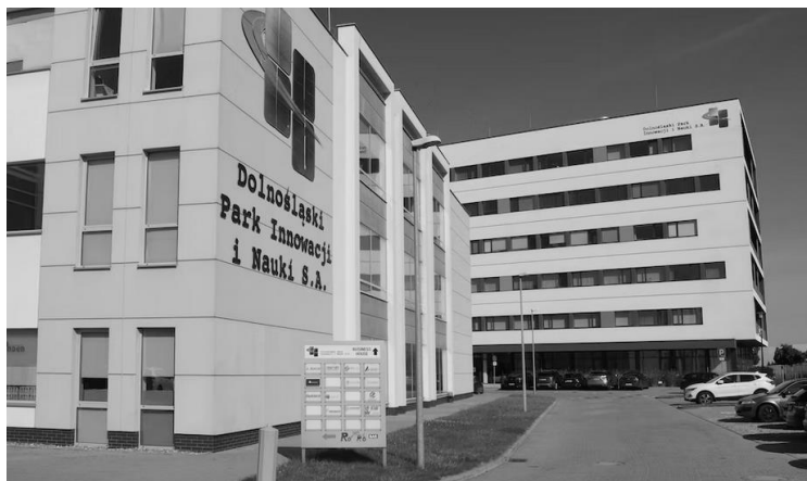
Rys. 1.14. Dolnośląski Park i Innowacji i Nauki S.A. w Wrocławiu [4]
